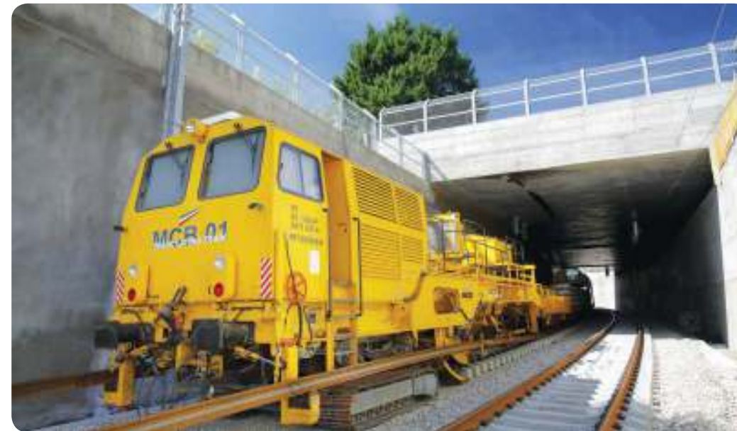
Treno di posa MCB 01
